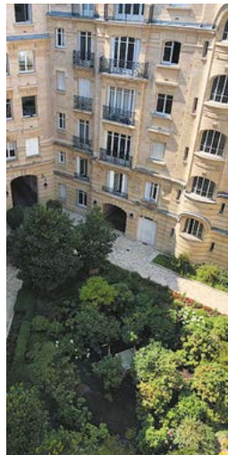
Rue de la Pompe, Paris 16 e
